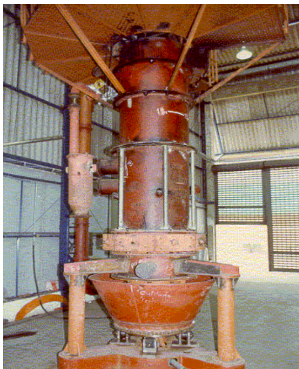
Figura 21 - Gaseificador de Leito Movente Instalado no IPT.
