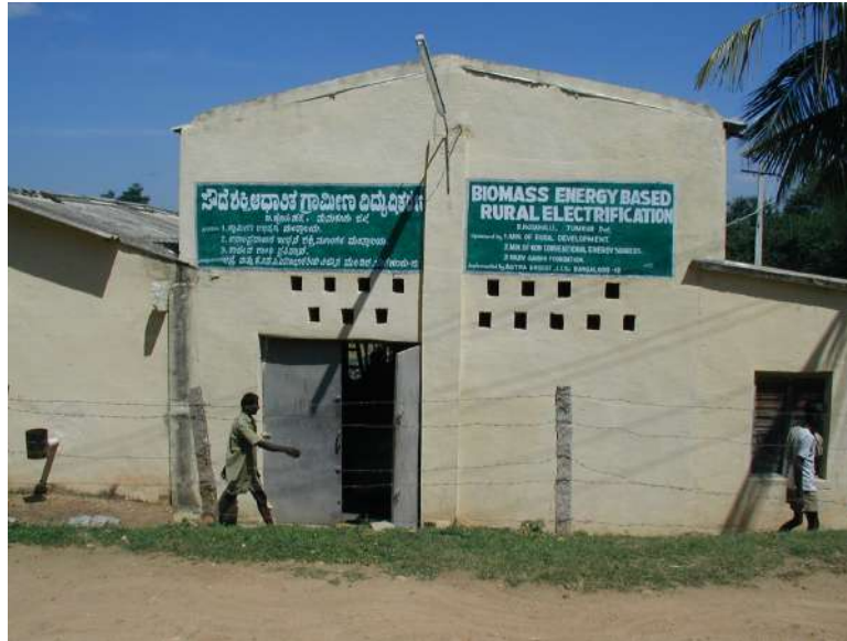
Figura 20. Casa que está instalado o sistema de gaseificação
